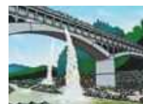
D 左岸連絡水路橋
