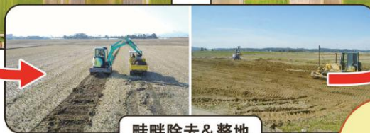
畦畔除去&整地
